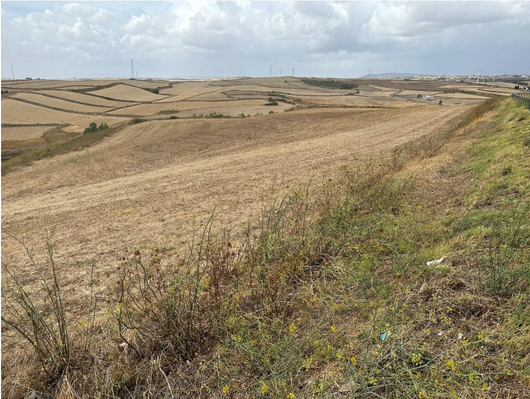
Figura 21 – Rilievo fotografico del percorso del cavidotto – Scatto 25
