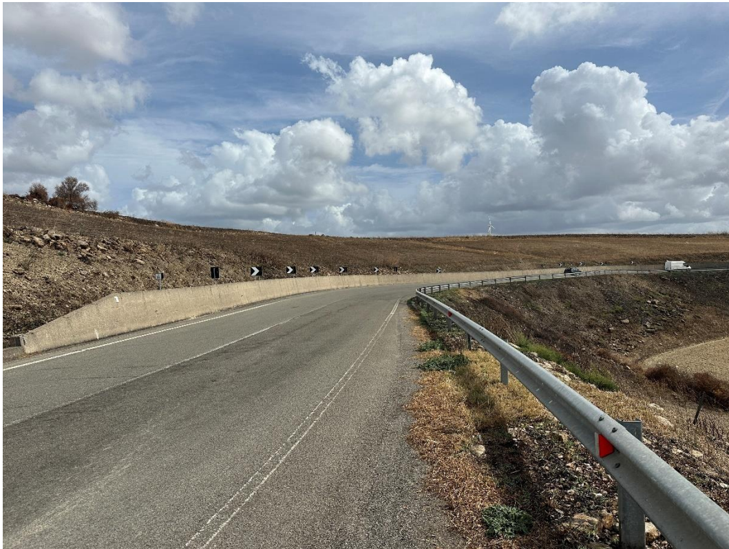
Figura 23 – Rilievo fotografico del percorso del cavidotto – Scatto 27
