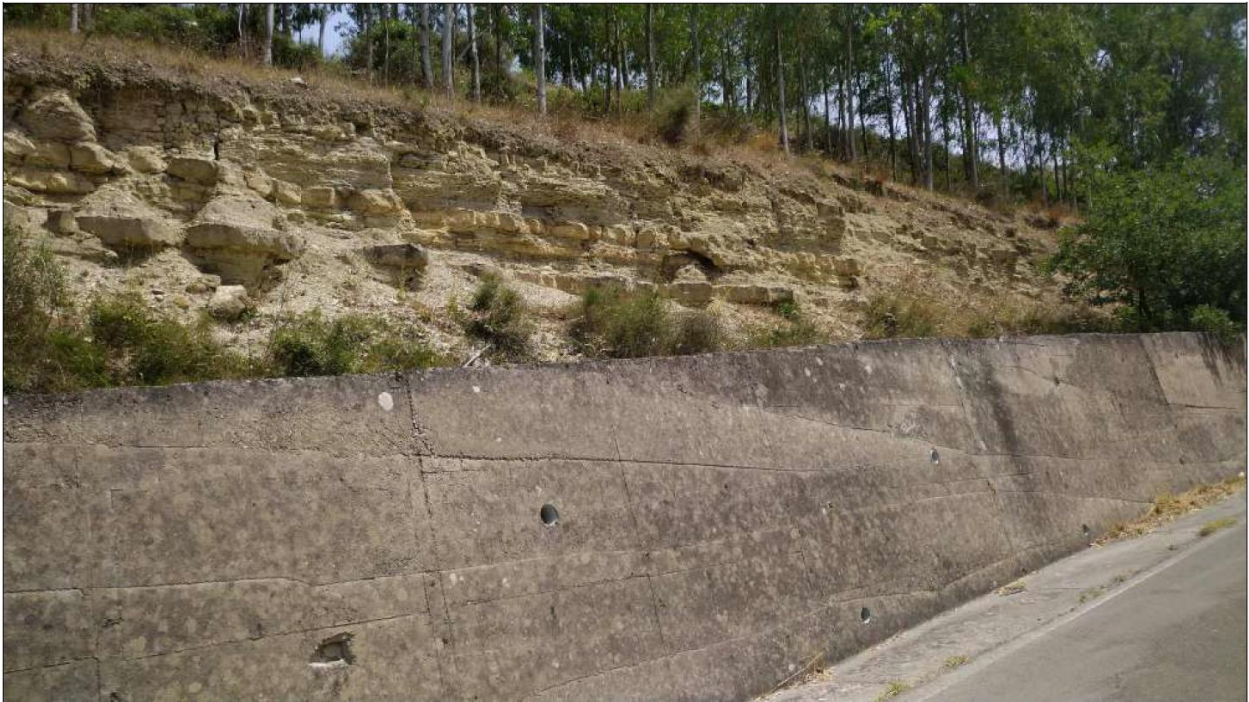
Figura 31 – Blocchi di arenaria e marne arenacee in sito visibili su taglio stradale - caratterizzanti i primi metri dei terreni agricoli presenti in località Pirixedda
