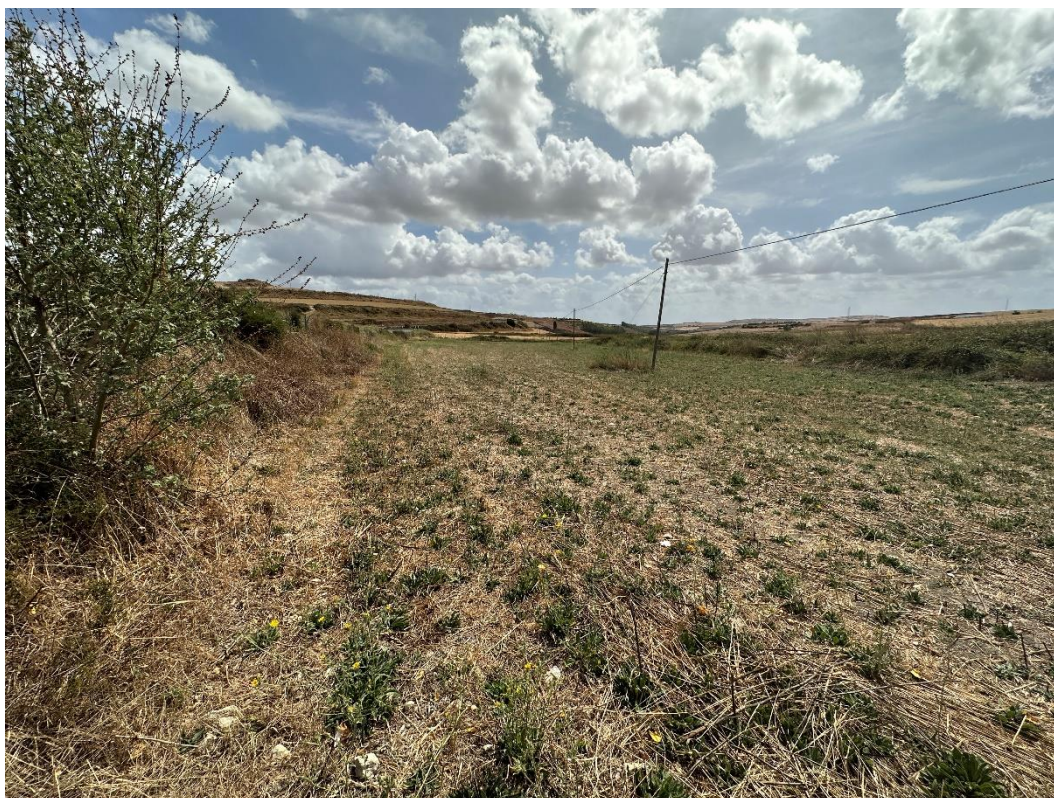
Figura 25 – Rilievo fotografico del percorso del cavidotto – Scatto 31
