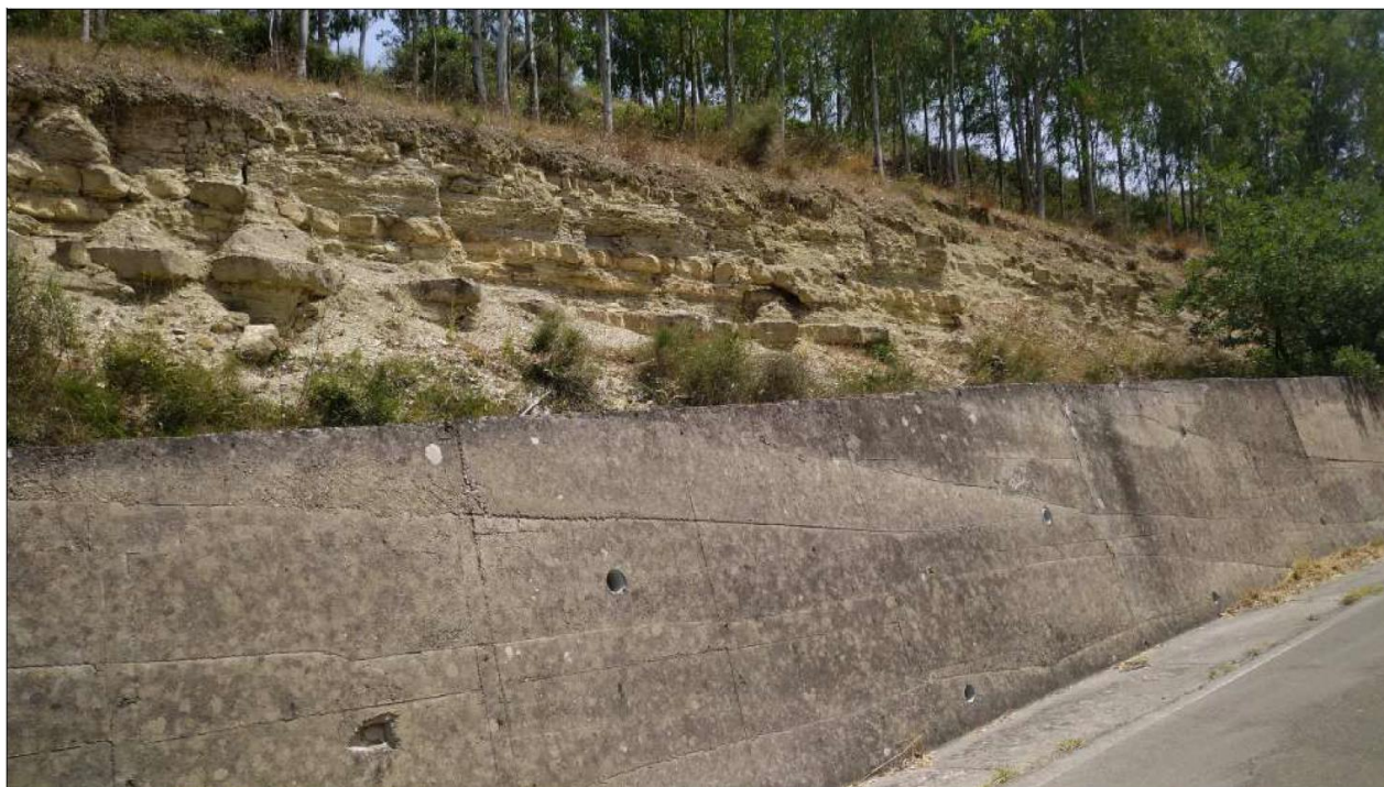
Figura 2 – Blocchi di arenaria e marne arenacee in sito visibili su taglio stradale - caratterizzanti i primi metri dei terreni agricoli presenti in località Pirixedda
