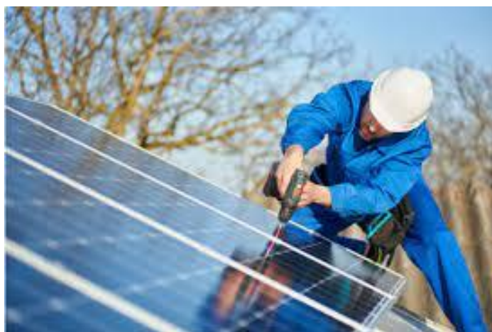
Figura 31: Fissaggio dei moduli fotovoltaici
