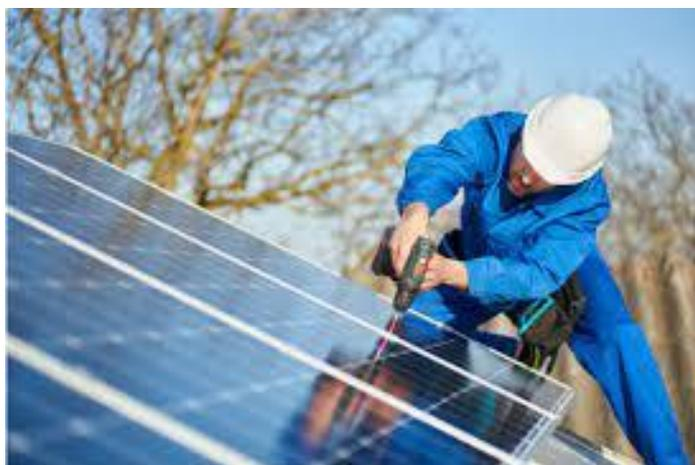
Figura 4: Fissaggio dei moduli fotovoltaici
