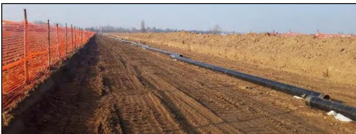
Foto 2.4/C – Sfilamento delle tubazioni di linea
