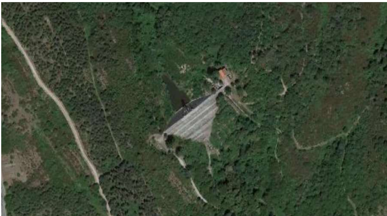
Figura 6 Foto aerea invaso (fonte: Google maps)
