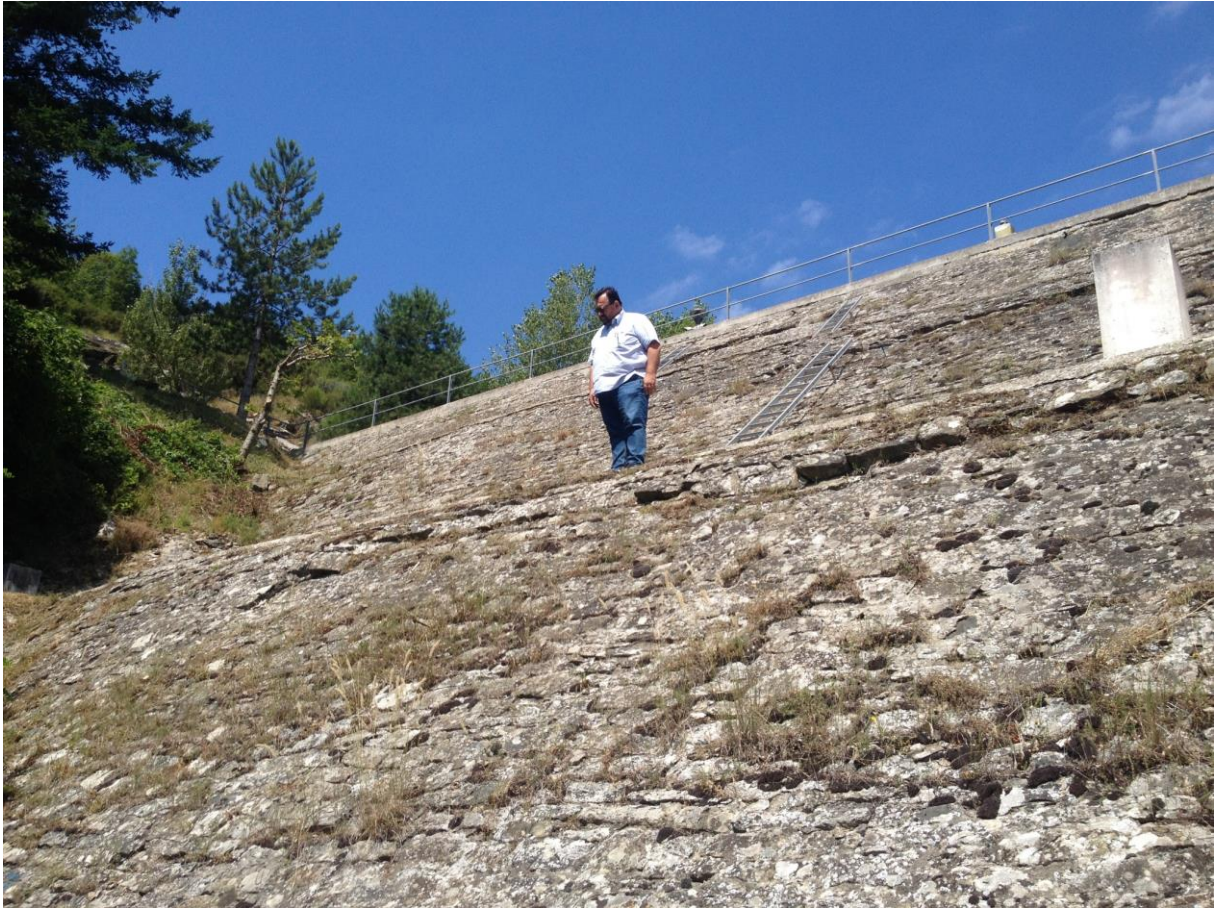
Figura 3-11: frattura presente nella zona destra del rivestimento murario di valle, appena al di sotto della prima berma dall'alto. La lesione ha andamento subparallelo ai filarotti dei conci in pietrame, con rigetto di alcuni centimetri del bordo superiore rispetto a quello inferiore della frattura.
