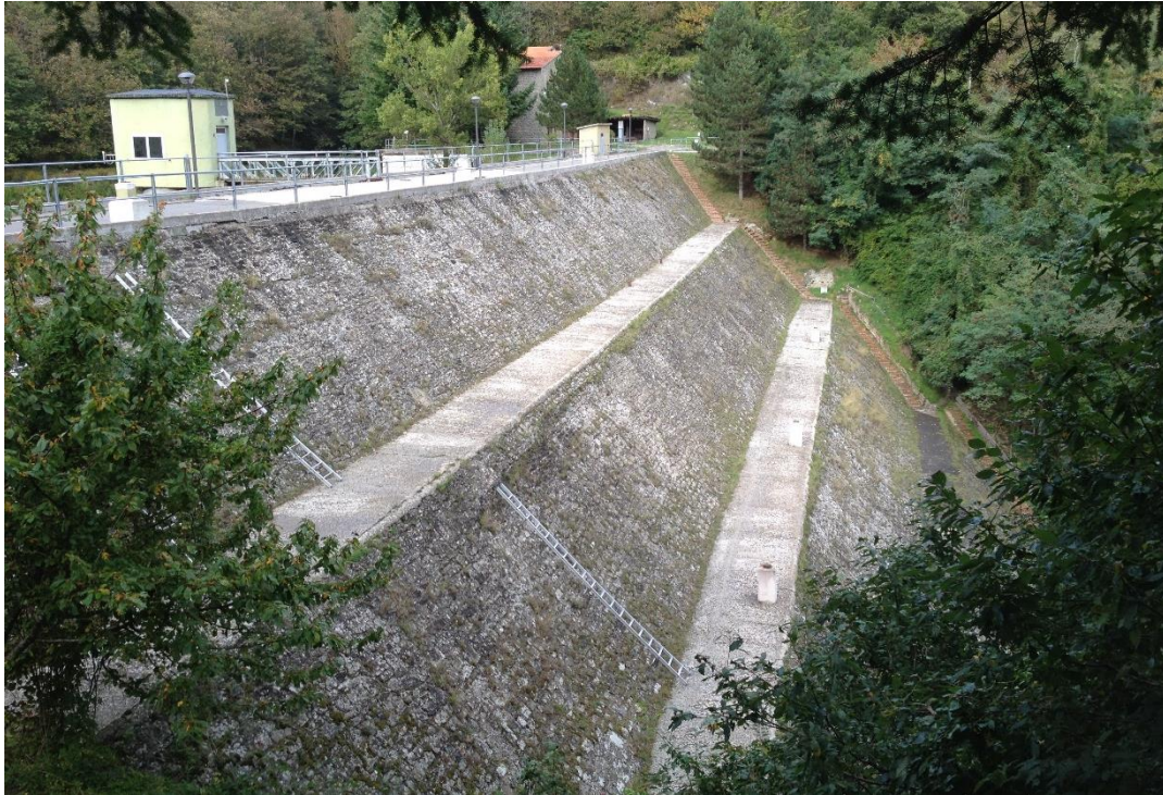
Figura 3-9: Vista dalla spalla destra del paramento di valle della diga.
