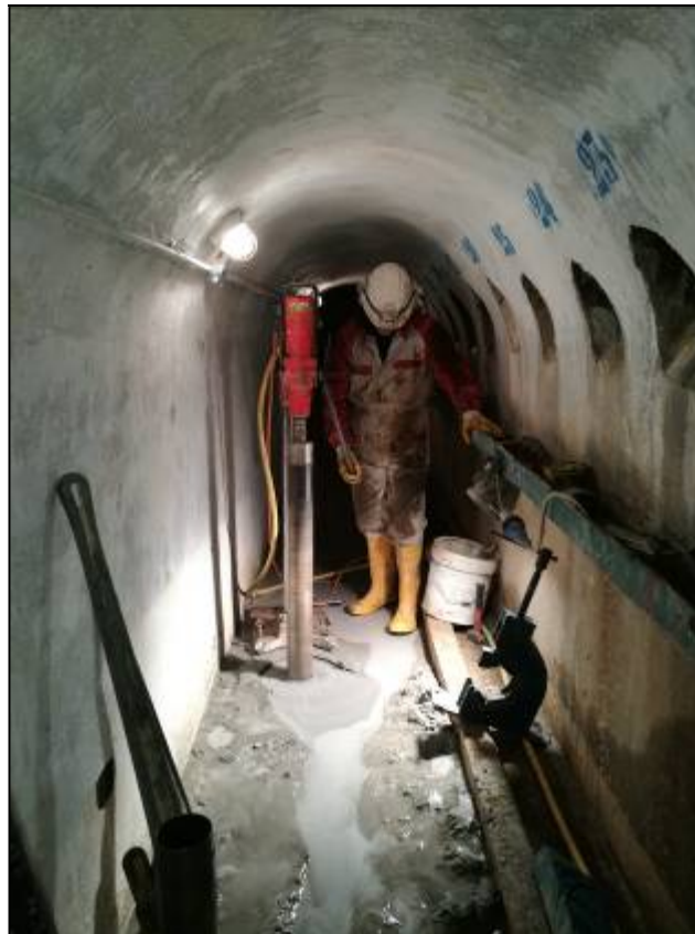
Figura 15 - Sondaggio interno al cunicolo
