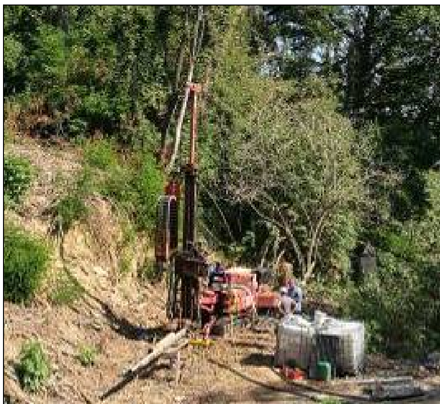
Figura 16 - Sondaggio a valle della diga
