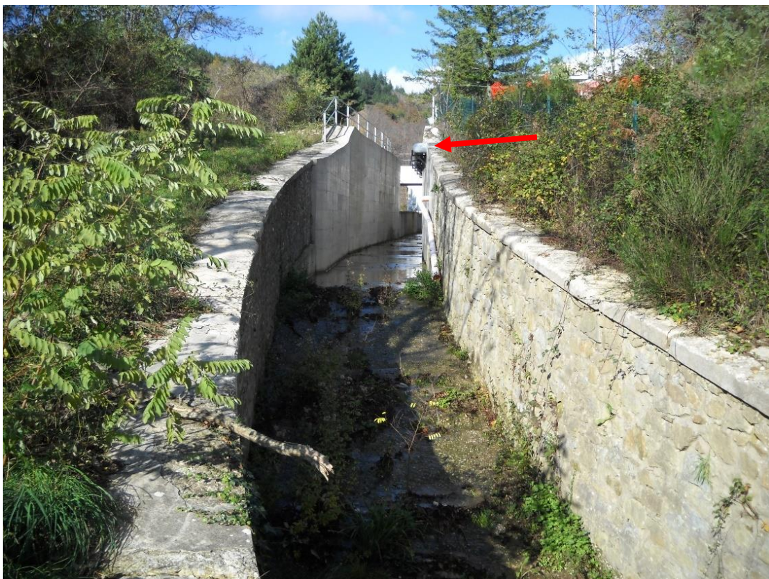
Figura 5-16: documentazione fotografica del tratto iniziale della canalizzazione che convoglia all'interno dell'invaso i deflussi generati dal cosiddetto "bacino imbrifero allacciato".
