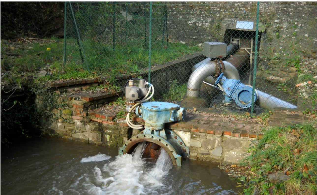
Figura 5-9: foto della sezione di sbocco dello scarico di fondo con valvola di regolazione a farfalla motorizzata.
