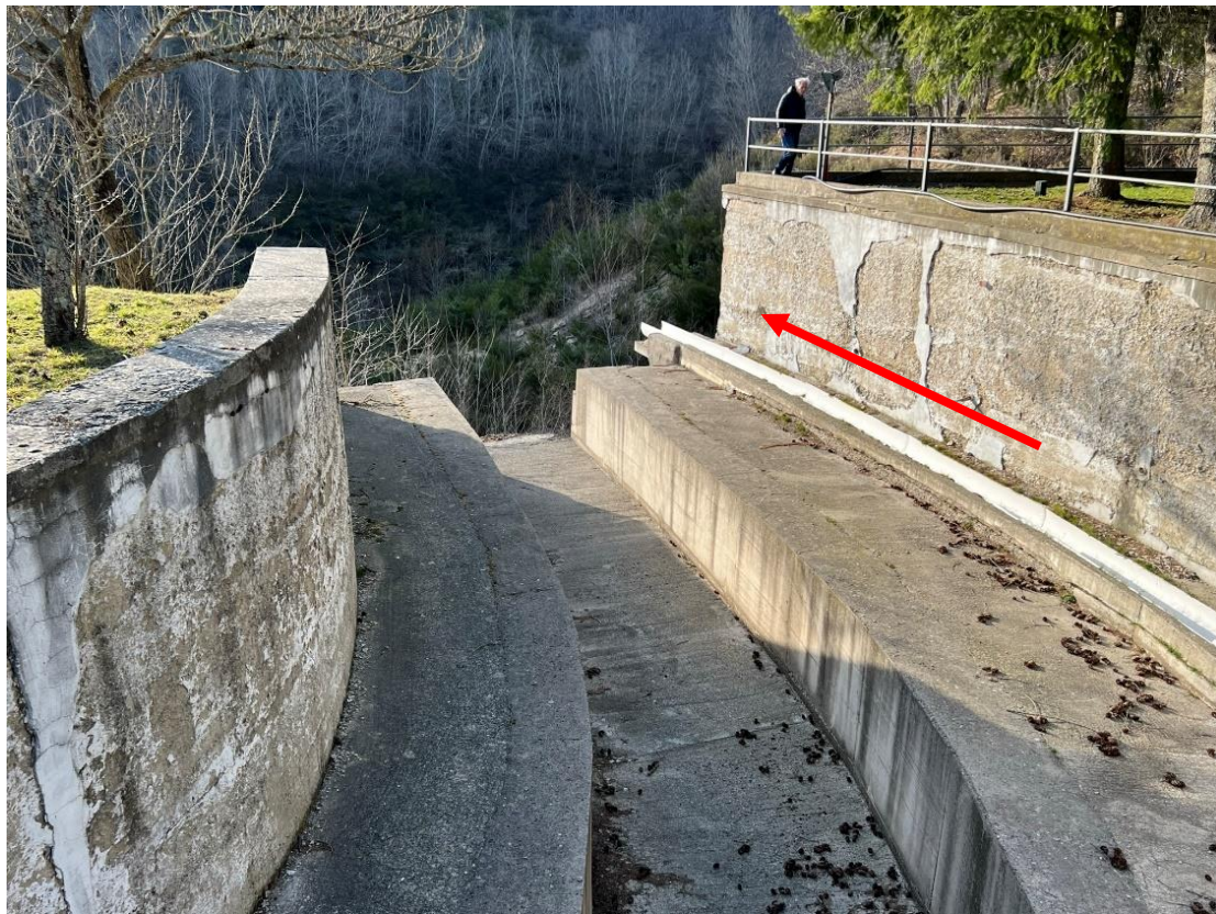
Figura 5-14: documentazione fotografica del tratto finale della canalizzazione che convoglia all'interno dell'invaso i deflussi generati dal cosiddetto "bacino imbrifero allacciato".
