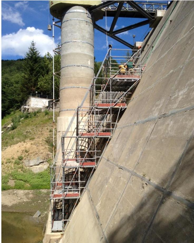
Figura 4: ponteggi impiegati per le indagini sul manto di monte
