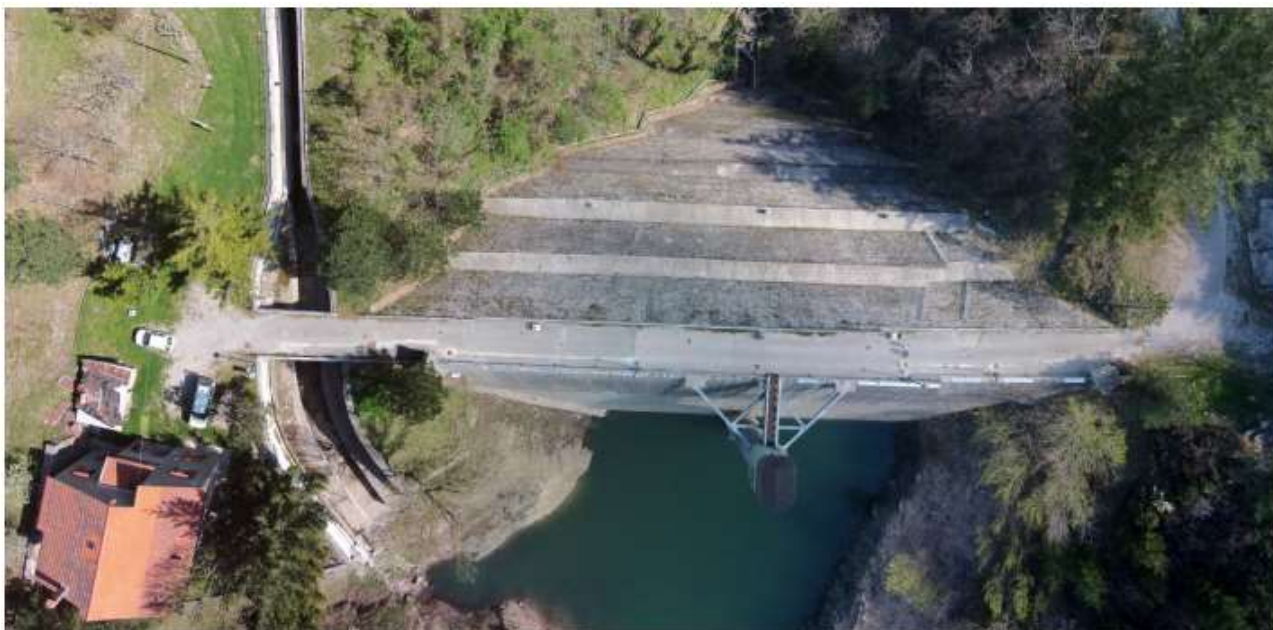
Figura 5 Vista aerea dello sbarramento (2015)
