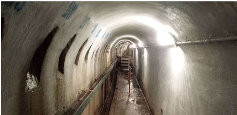
Figura 9 Cunicolo di ispezione e sbocco dei condotti di drenaggio
