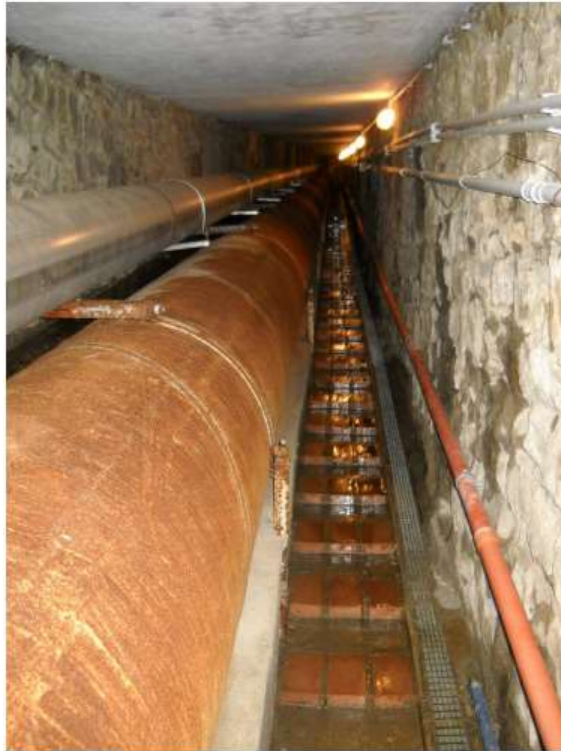
Figura 11 Cunicolo d'ispezione dello scarico di fondo e della condotta di derivazione
