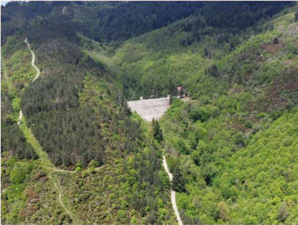
Figura 80 Fotografia stato attuale
