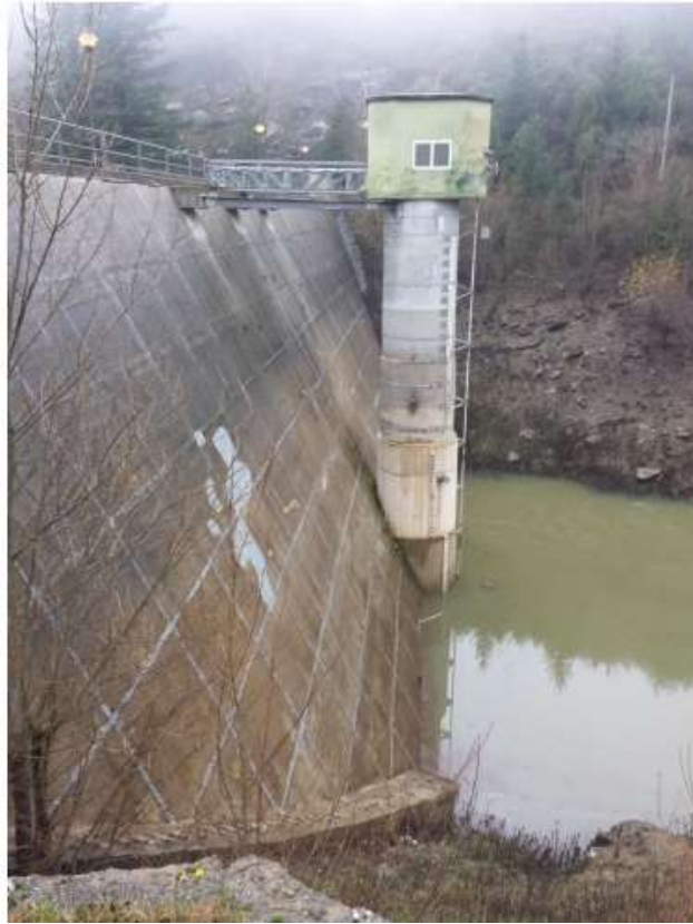
Figura 12 Paramento di monte della diga
