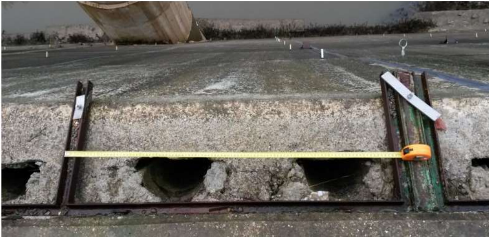
Figura 8 Imbocco dei condotti di drenaggio
