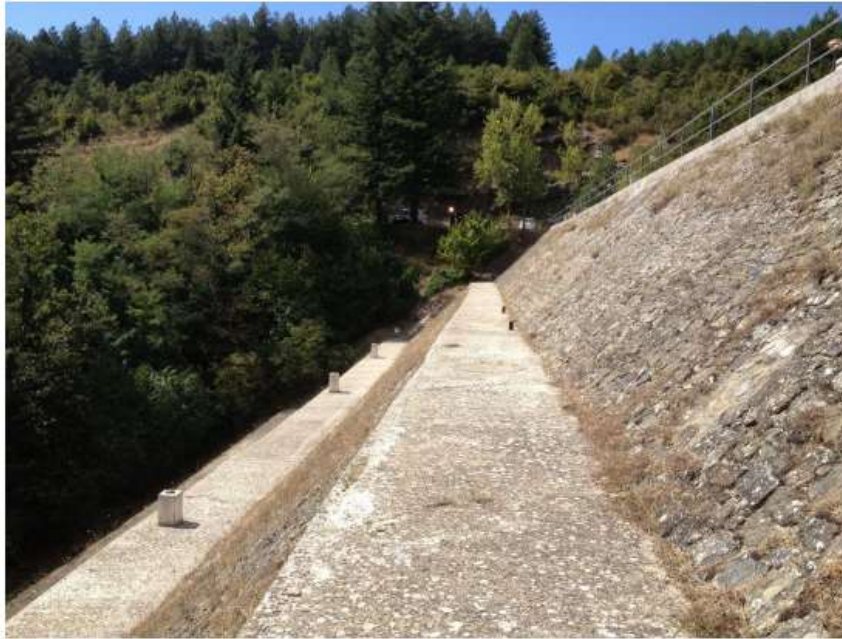
Figura 13 Vista dalla spalla sinistra del paramento di valle della diga
