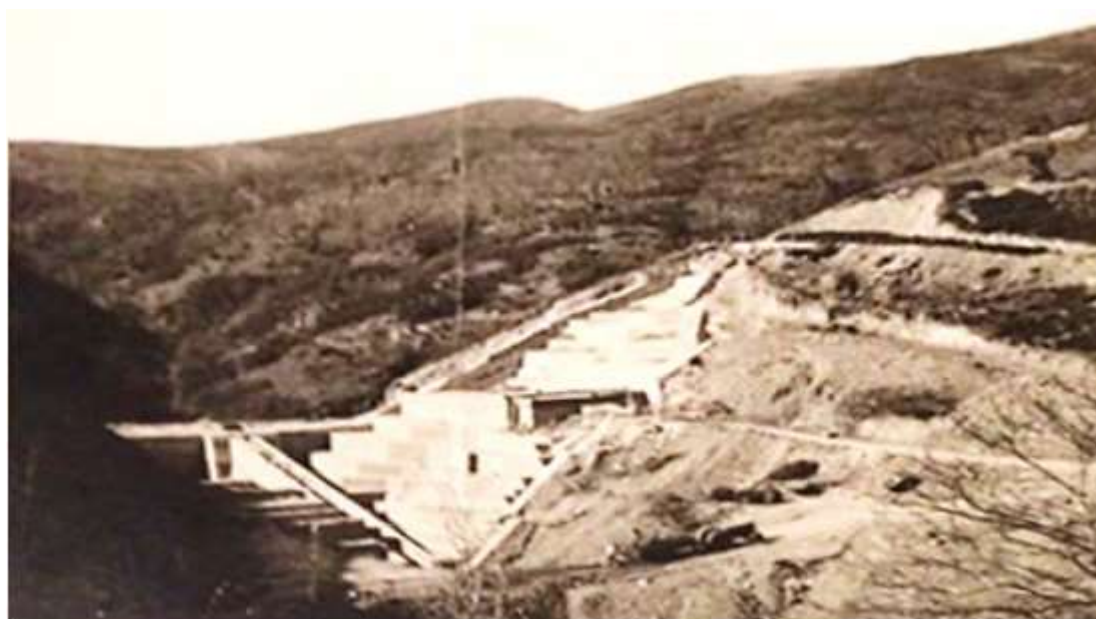
Figura 2 Vista da valle del cantiere nella fase precedente alla formazione del corpo diga. Si notano le strutture fondali e la base del cunicolo dello scarico di fondo
