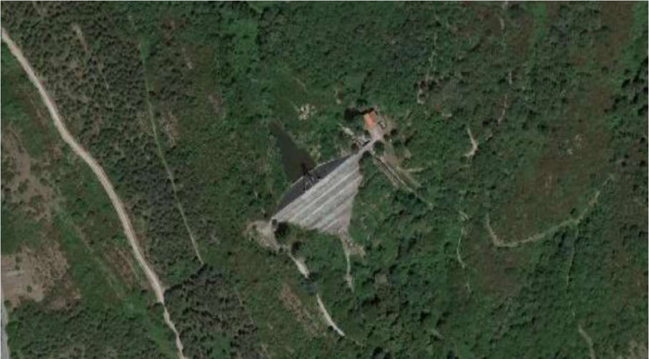
Figura 2 Foto aerea invaso (fonte: Google maps)
