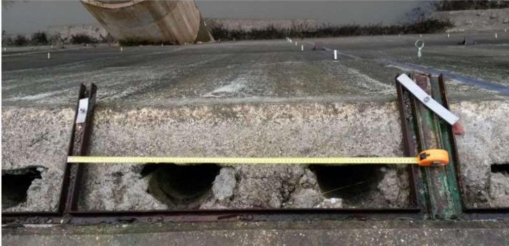
Figura 5 Imbocco dei condotti di drenaggio
