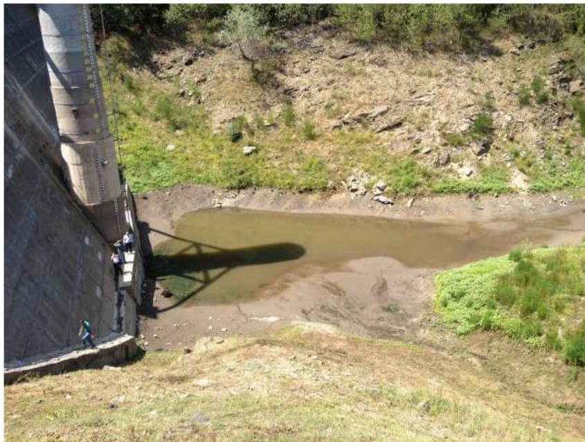
Figura 11 Vista a serbatoio vuoto sulla parte emergente dal terreno (al piede del manto di tenuta del paramento di monte) del blocco di fondazione al cui interno si sviluppa il cunicolo d'ispezione dei drenaggi
