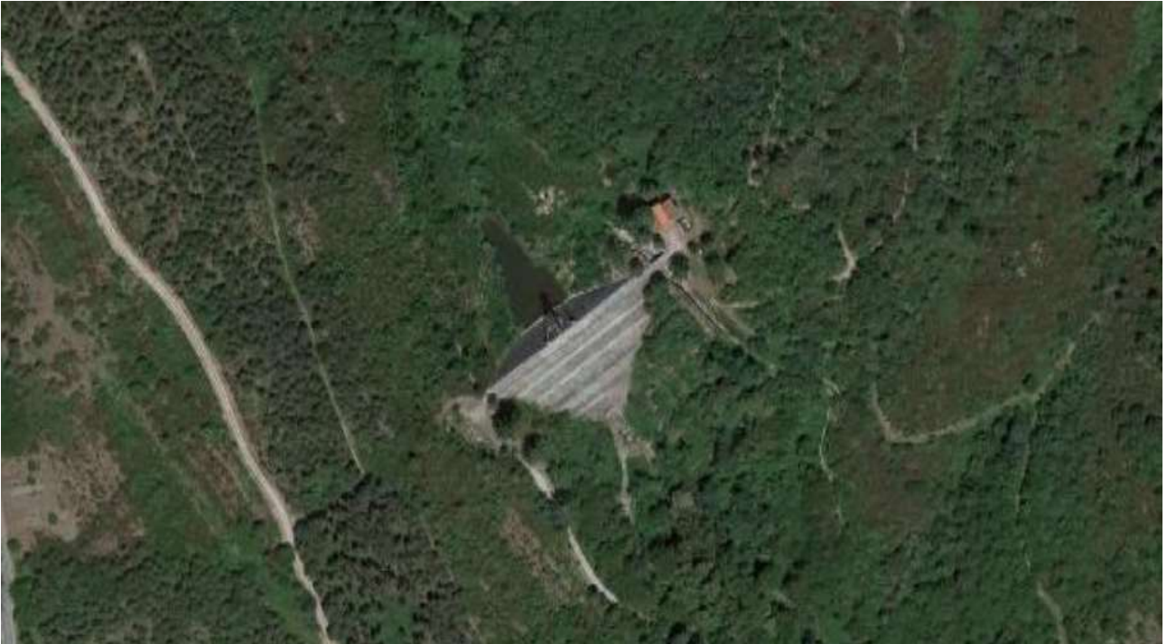
Figura 18 Foto aerea invaso (fonte: Google maps)
