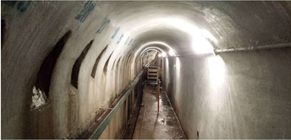
Figura 6 Cunicolo di ispezione e sbocco dei condotti di drenaggio
