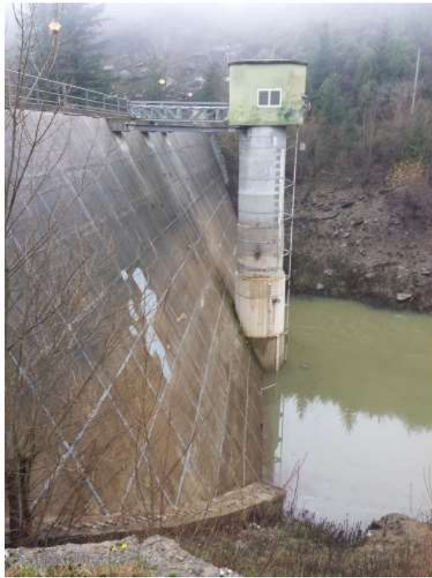
Figura 9 Paramento di monte della diga
