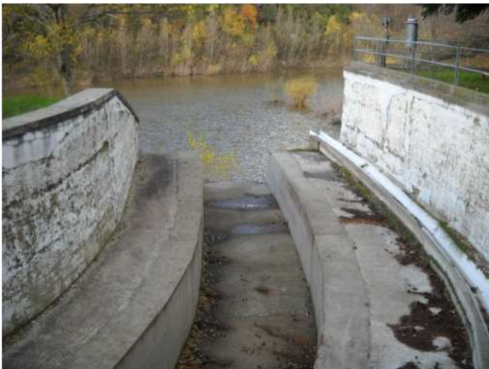
Figura 7 Vista dell'imbocco del canale fugatore dello scarico di superficie a soglia libera.
