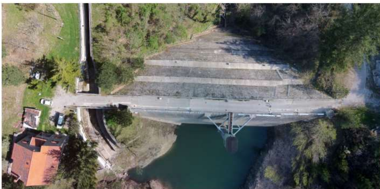
Figura 2 Vista aerea dello sbarramento (2015)
