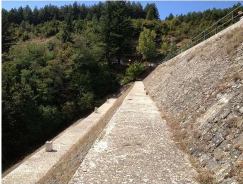
Figura 10 Vista dalla spalla sinistra del paramento di valle della diga
