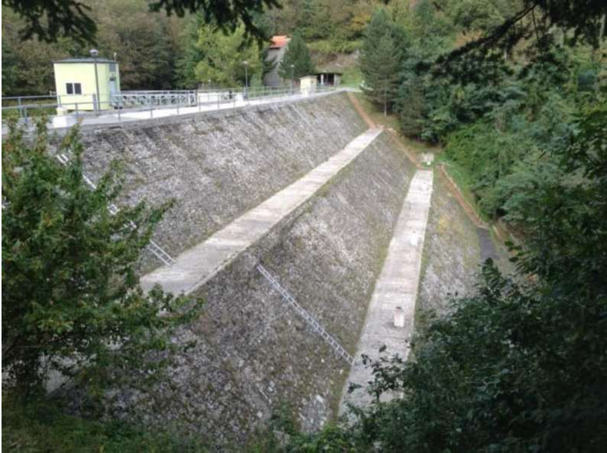
Figura 3 - Paramento di valle
