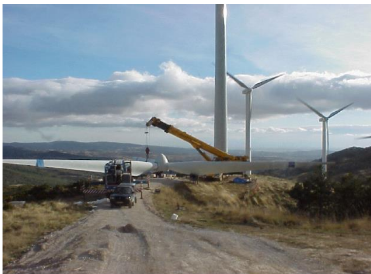
Figura 2-3: Ingombro del rotore a terra
