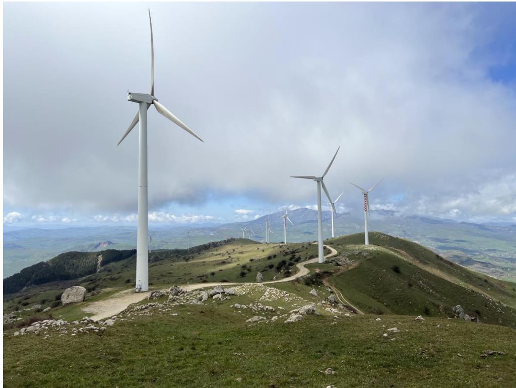
Figura 6-2: Ripresa da terra in sito - Documentazione fotografica (Studio di Incidenza Ambientale – allegato 4)
