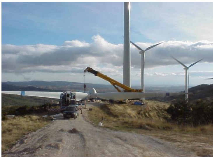
Figura 4-4: Ingombro del rotore a terra
