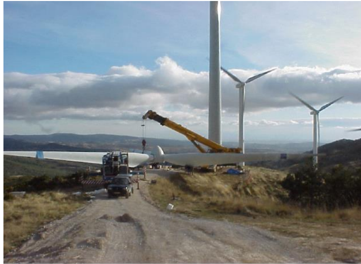
Figura 4-2: Ingombro del rotore a terra
