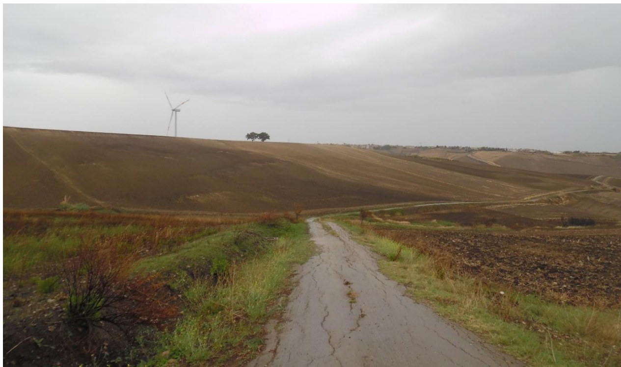
Figura 3 – Stato dei luoghi dell'area nord di progetto vista verso nord
