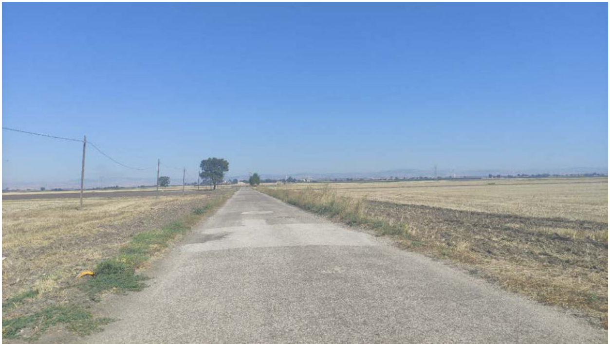
Vista della strada comunale al margine della quale (nel terreno non facente parte della sede stradale) verrà realizzato il cavidotto di collegamento MT tra l'impianto e la sottostazione di consegna e trasformazione 30/36 kV.
