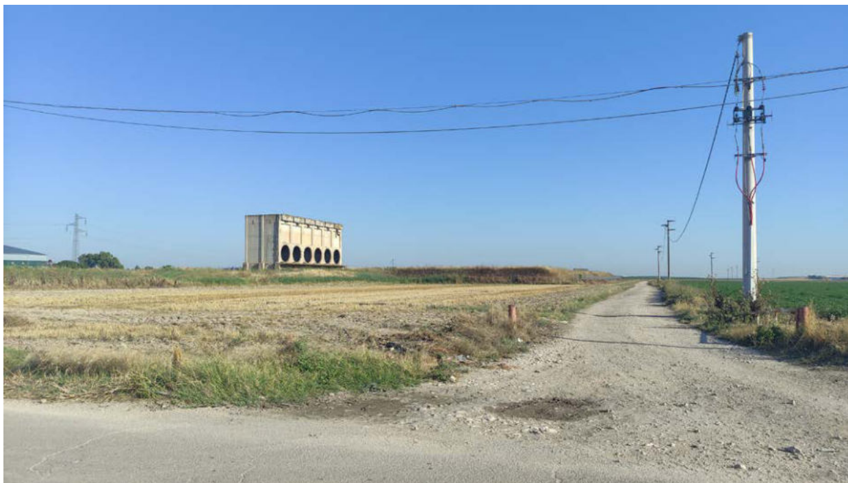
Vista della strada d'accesso alle aree interessate dall'intervento, dalla strada SP22. Sullo sfondo un edificio dell'ex zuccherificio dell'Eridania.
