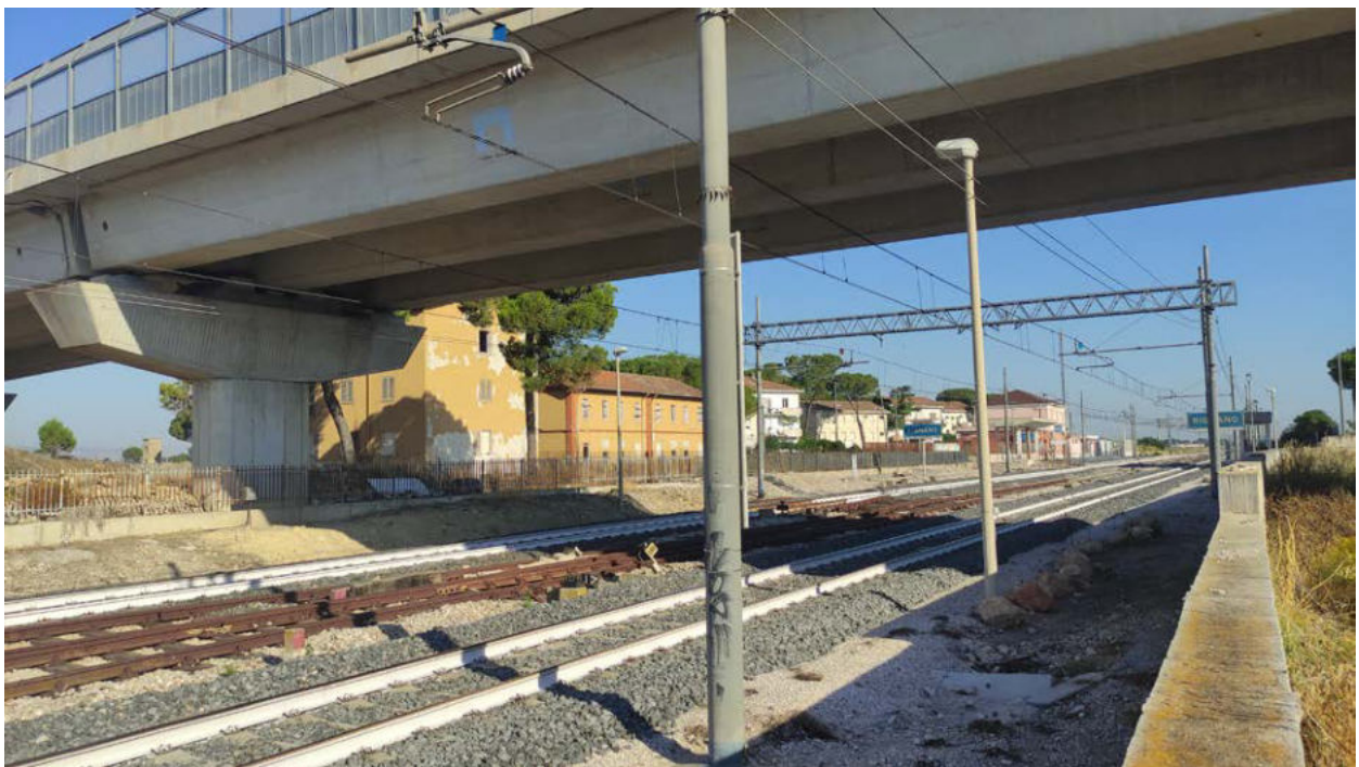
Vista della stazione ferroviaria "Rignano" nei pressi dell'area interessata dal progetto.
