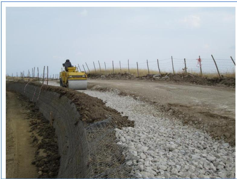
*Figura 23 – Esempio di opera in terre rinforzate - Fonte HE*
