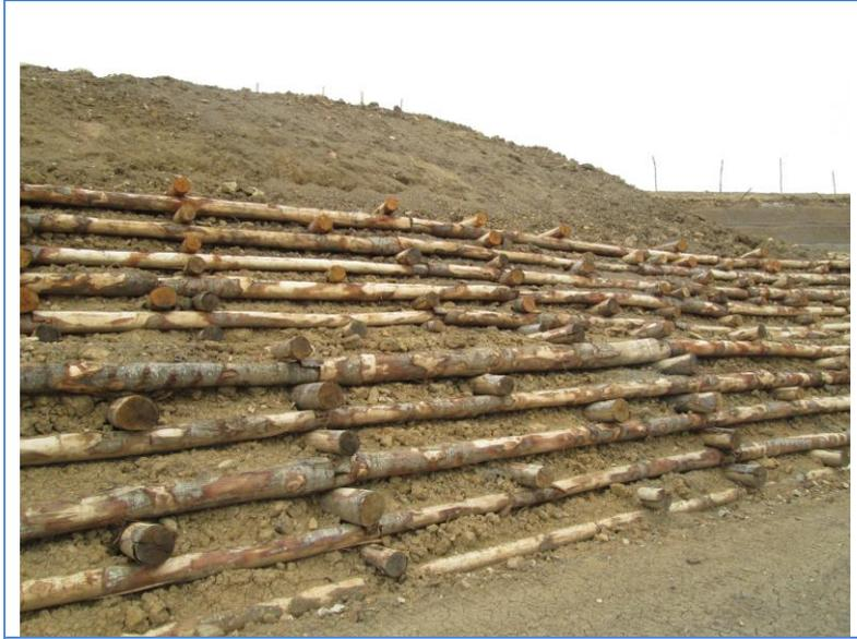
*Figura 22 – Esempio di opera in palificate in legname - Fonte HE*
