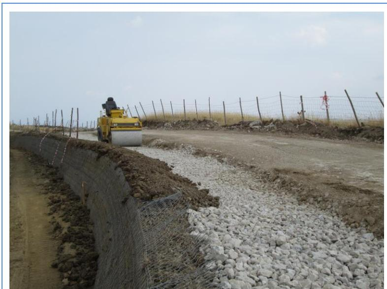
*Figura 33 – Esempio di opera in terre rinforzate - Fonte HE*
