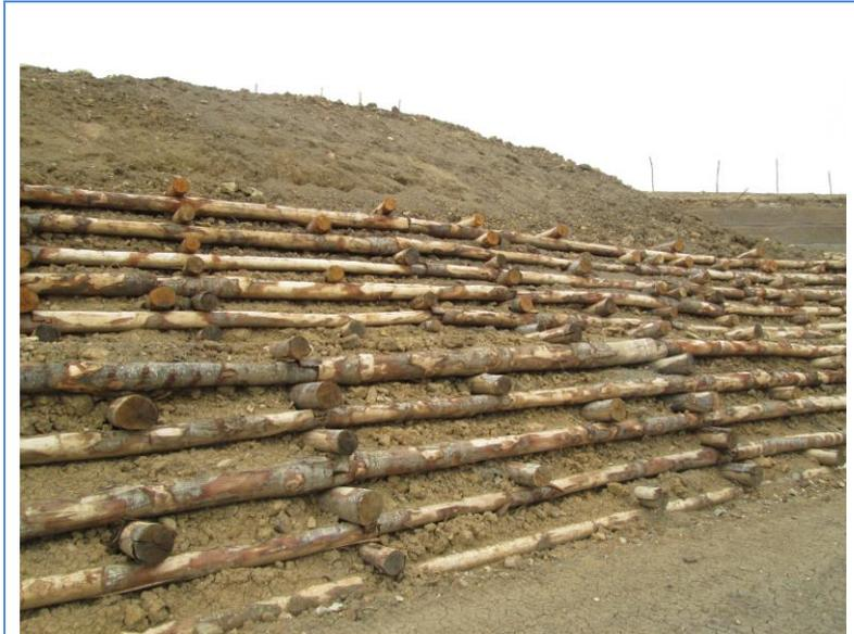
*Figura 32 – Esempio di opera in palificate in legname - Fonte HE*
