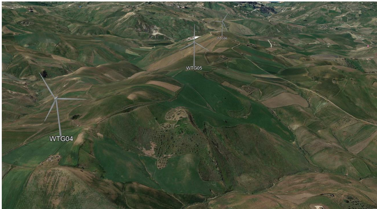
Figura 14 - Panoramica ubicazione aerogeneratori WTG04- WTG05-WTG06. (Google Earth)
