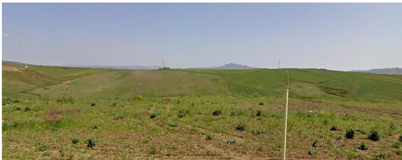
Figura 10- Panoramica area di installazione aerogeneratore WTG02
