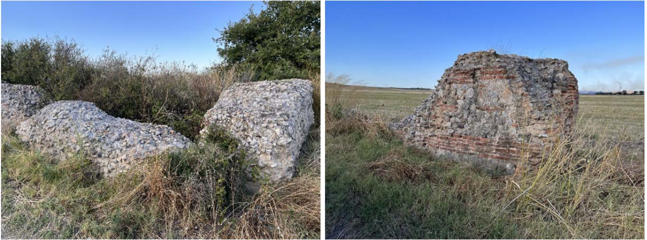
Figg. 32-33. Le strutture murarie individuate nei pressi di Mass. Abbazia
