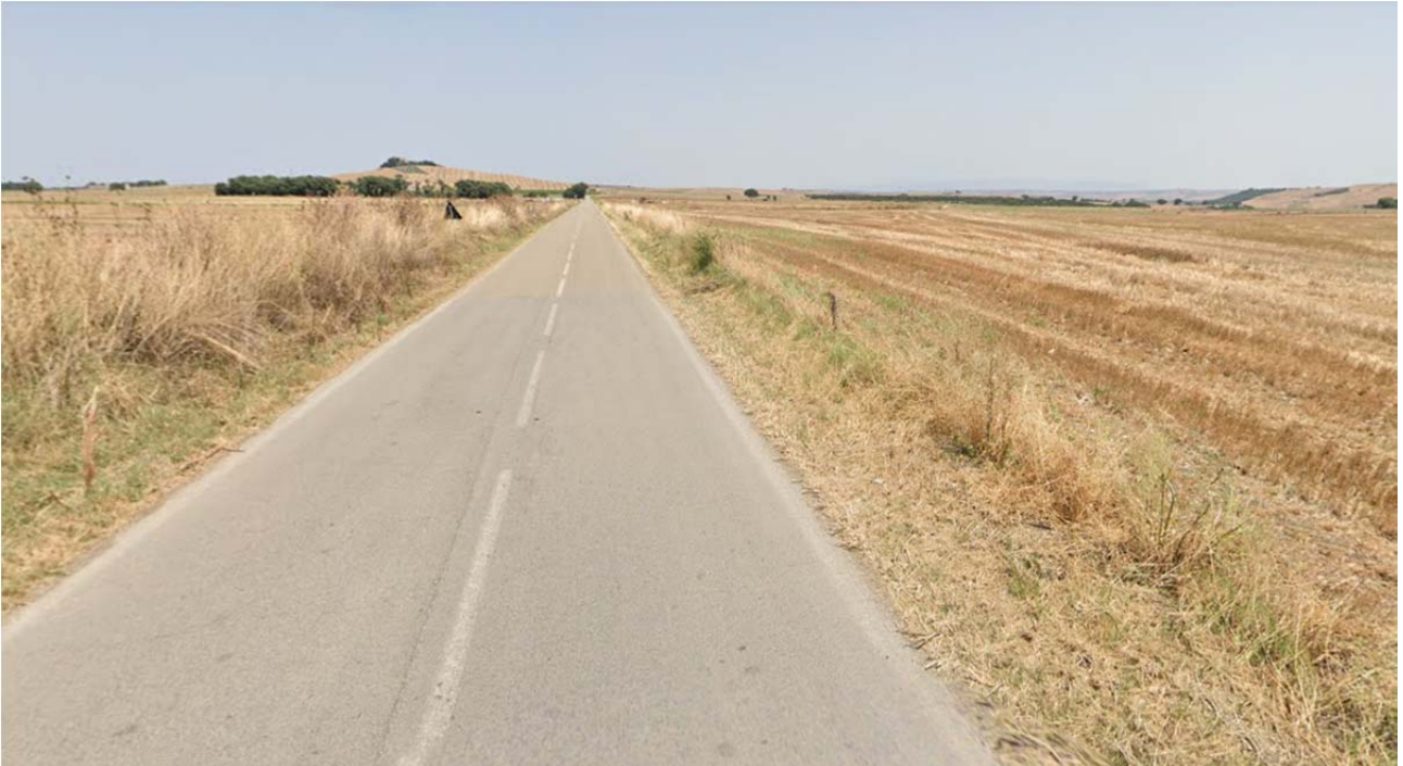
Fig. 17. Esempio di visibilità nella porzione interessata dal cavidotto (SR 376 Maglianica in loc. Piano Palazzo )
