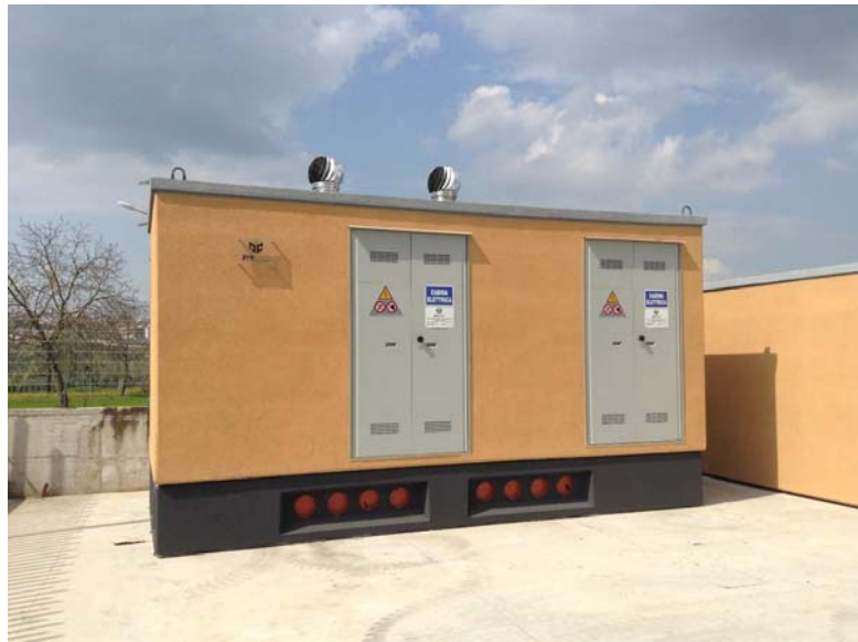
Figura 4: Tipica cabina di smistamento
