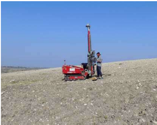
FOTO 3 - ESECUZIONE PROVA DPSH 3
