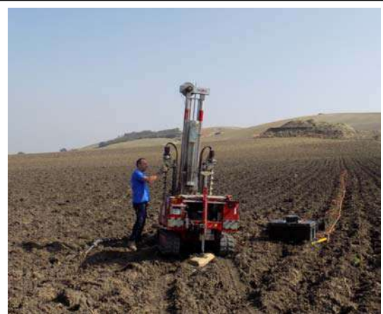
FOTO 4 - ESECUZIONE PROVA DPSH 4
