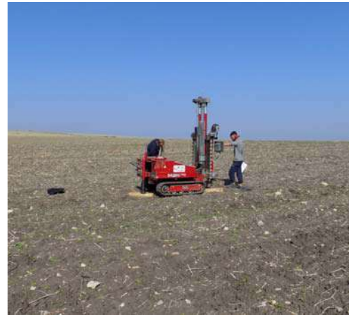
FOTO 2 - ESECUZIONE PROVA DPSH 2
