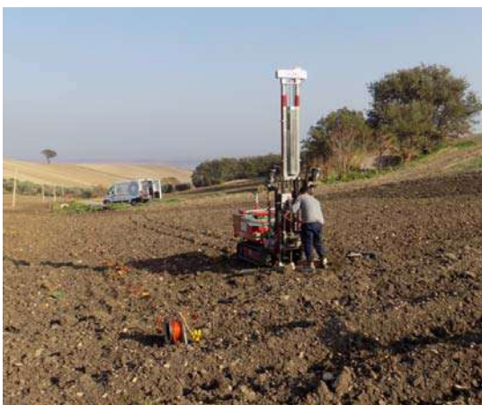
FOTO 5 - ESECUZIONE PROVA DPSH 5
