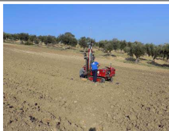
FOTO 6 - ESECUZIONE PROVA DPSH 6
