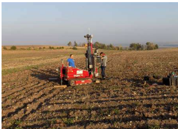
FOTO 7 - ESECUZIONE PROVA DPSH 7
