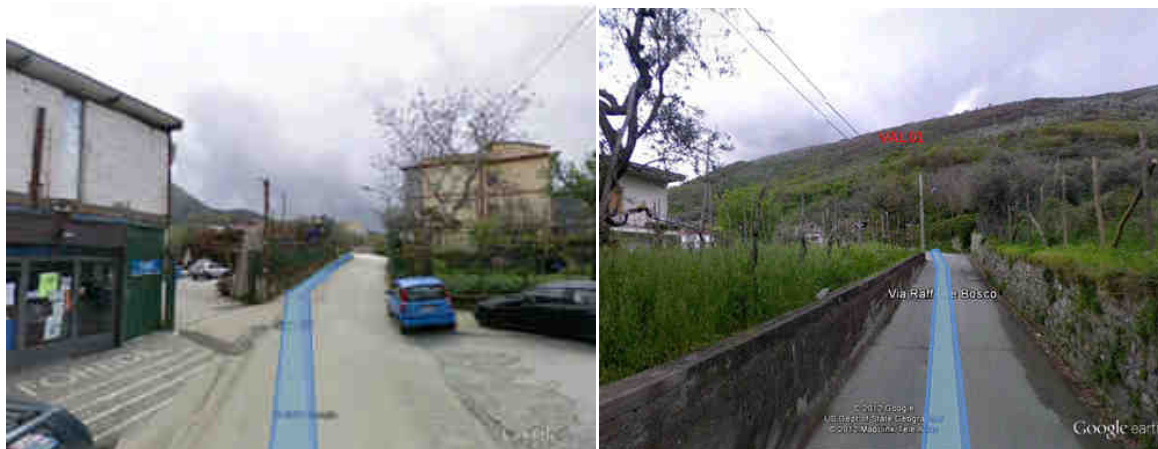
Figure 10 - 11: cavo in uscita dalla CP del comune di Vico lungo Via Raffaele Bosco e collegamento al VAL01.
