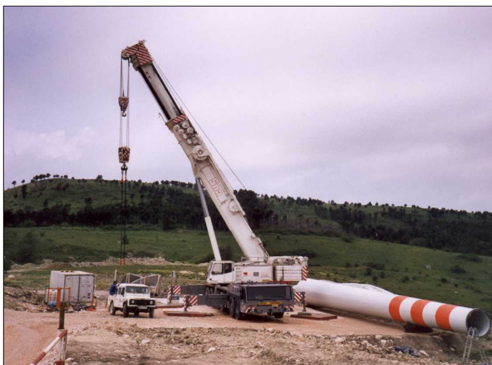
Figura 1.4.6.-1.: Fase di montaggio di un aerogeneratore.
