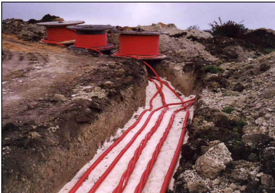
Figura 1.4.7.-1.: Particolare della posa cavi elettrici.
