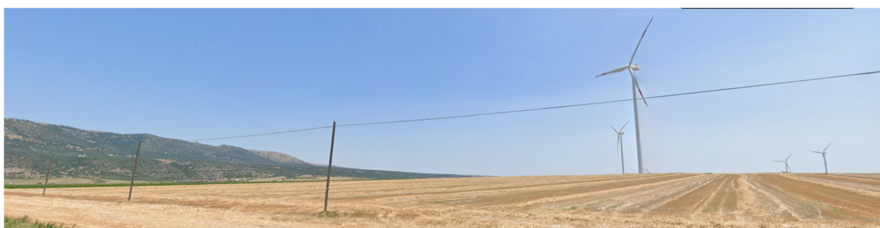
Figura 16 : Vista dell'area d'impianto in prossimità dell'aerogeneratore A5 dalla SP n.22.
