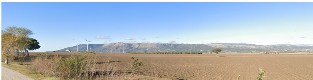
Figura 18: Vista dell'area d'impianto in prossimità dell'aerogeneratore A7 dalla SP n.25.
