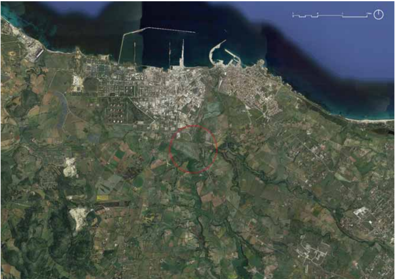
Fig.2 Estratto fotogrammetrico con indicazione (cerchio rosso) dell'area oggetto di intervento
