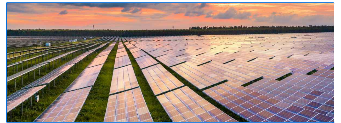
Impianto Di Produzione Di Energia da Fonte Solare Fotovoltaica Denominato "New Sun 1"
