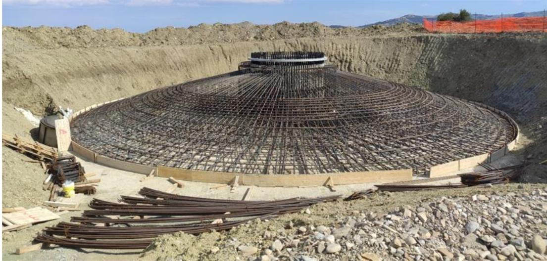
**Figura 6.5: immagine tipo armature plinto**
