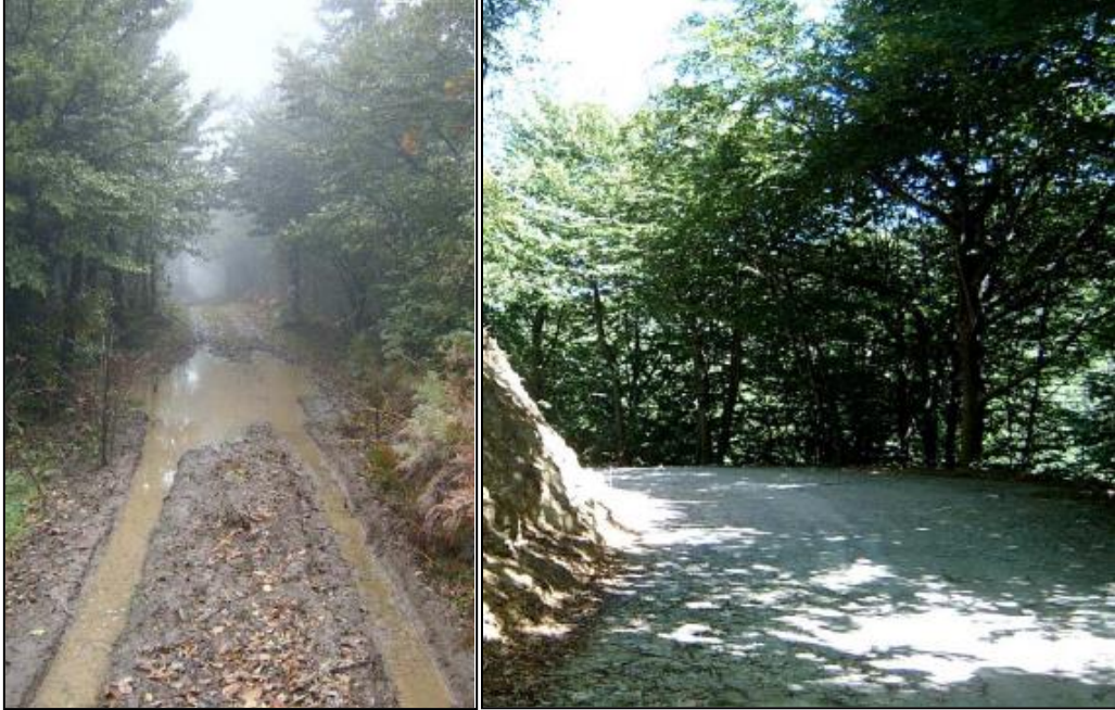
Figura 15: Strade di accesso prima e dopo i lavori di sistemazione
