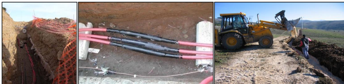
Figura 19: Posa cavi interrati
