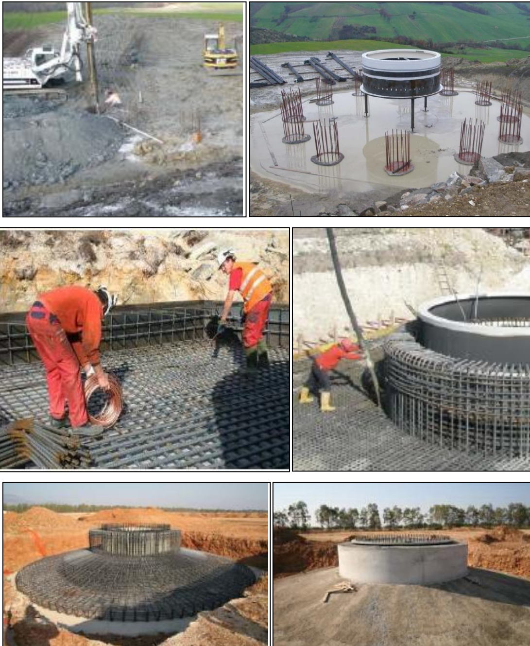
Figura 17: Fondazione aerogeneratore con pali
