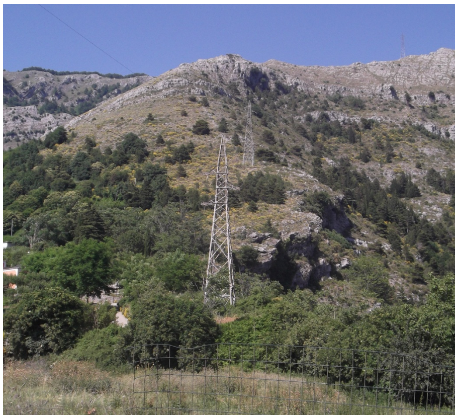
Foto 5 versante meridionale del rilievo Punta Medico con ubicazione dei sostegni VAL11, in primo piano davanti al sostegno esistente, VAL12, in secondo piano davanti al sostegno esistente, e VAL13, alla sommità del rilievo.
