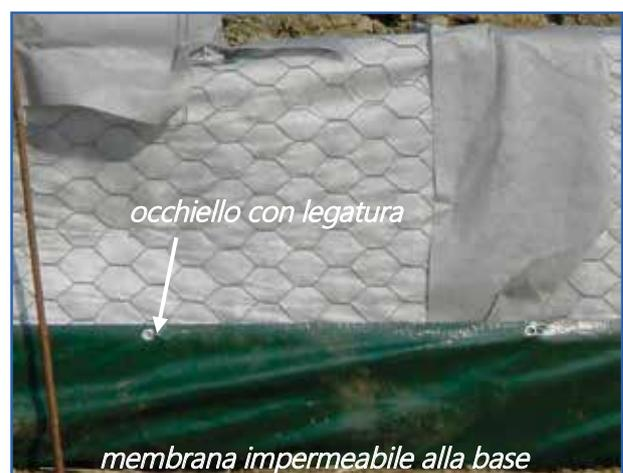
Terminate le operazioni di assemblaggio e legatura del sistema GABBIODREN® si procede calando la pannellata mediante macchine operatrici o con l'ausilio di corde.
