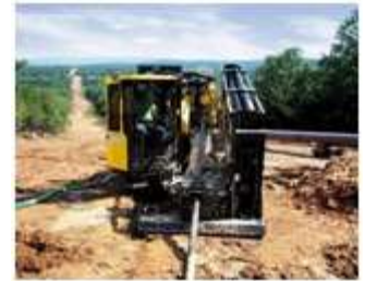
PERFORAZIONI MEDIANTE LA NO-DIG
