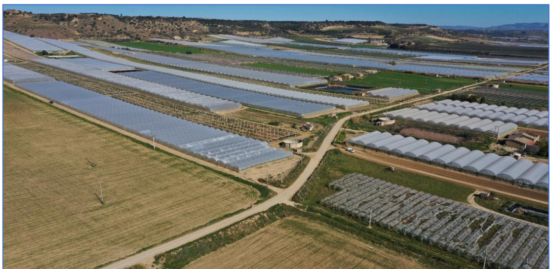
Figura 15 - Report fotografico areale di intervento
