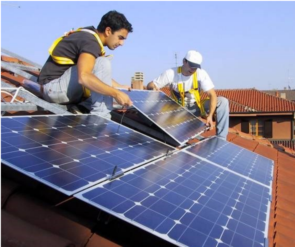
Figura 6 Operai montatori di pannelli fotovoltaici su solai di copertura
