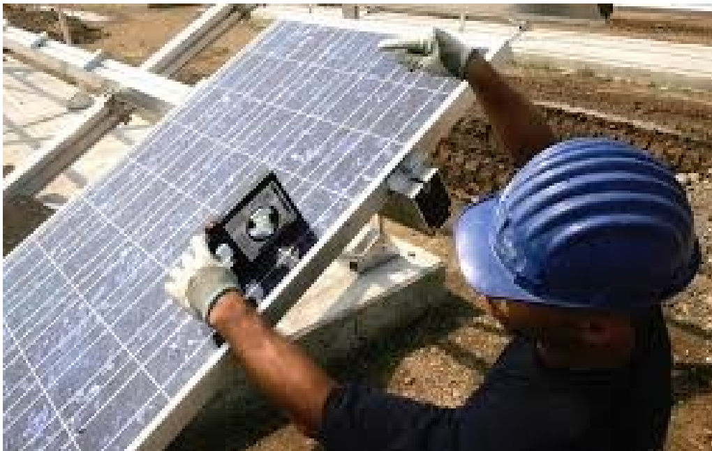
Figura 7 Operai montatori di pannelli fotovoltaici su suolo
