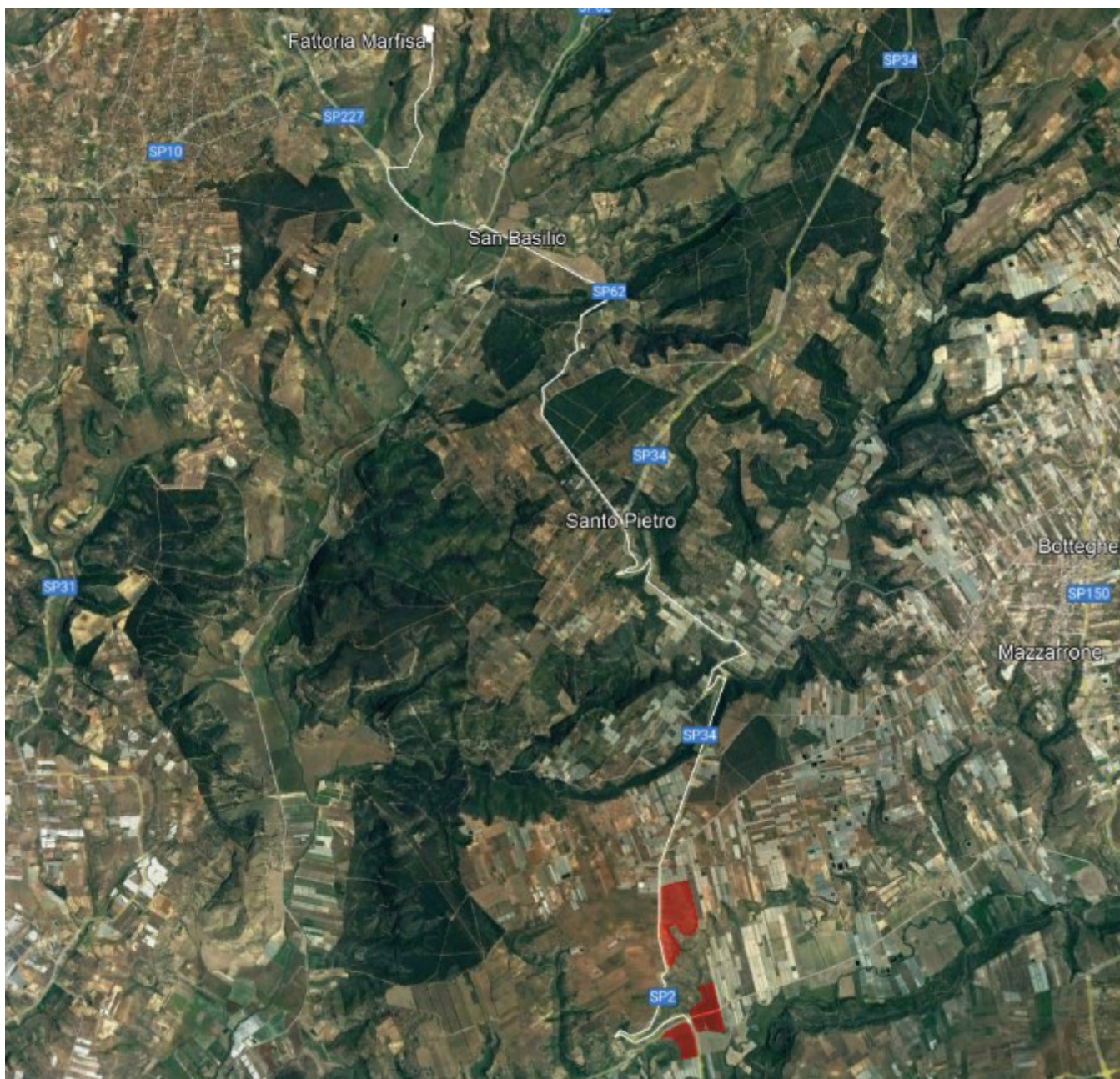
Figura 3 Area impianto FV con cavidotto ed opere di connessione alla RTN nel comune di Caltagirone (CT) su foto satellitare (fonte Google LLC.)
