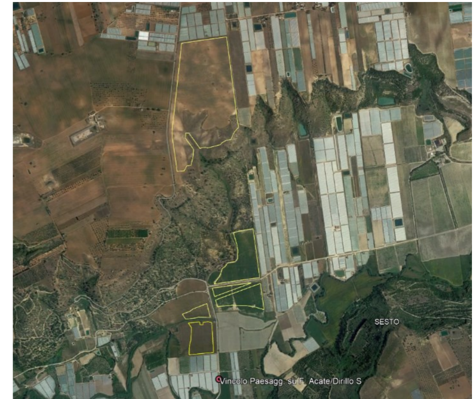
Figura 150. Foto satellitare del punto di vista fotografico (in rosso), impianto fotovoltaico (giallo)
