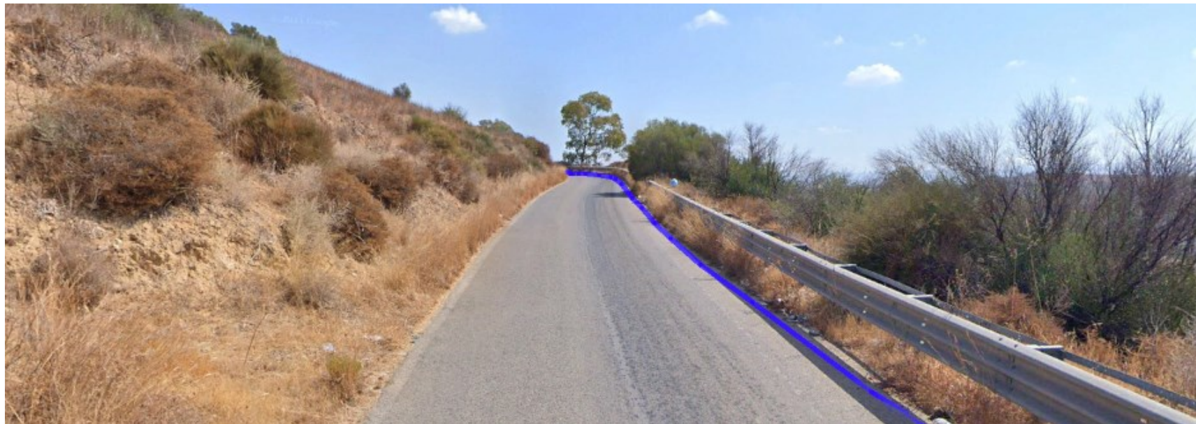
Figura 39. Vista dell'interferenza del cavidotto MT (linea blu)
