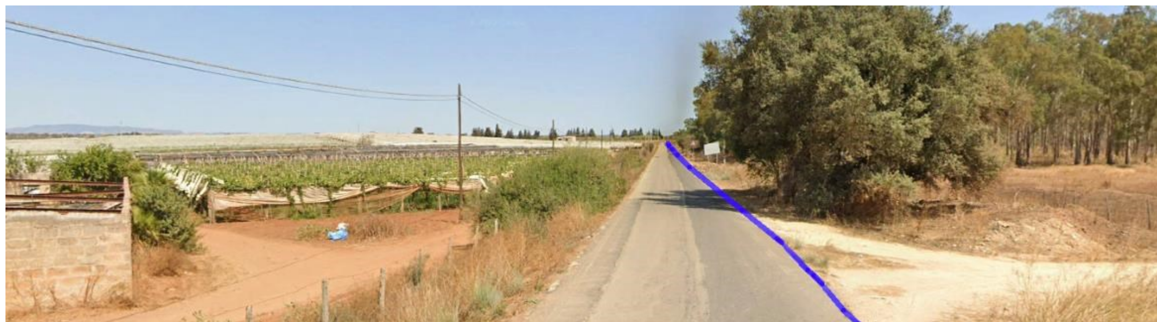
Figura 39. Vista dell'interferenza del cavidotto MT (linea blu)
