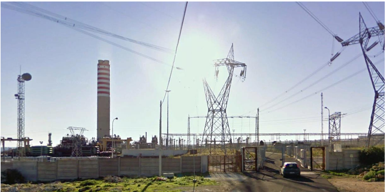
Figura 22 - Stazione TERNA prevista per la connessione alla rete elettrica ubicata nel territorio comunale di Priolo Gargallo (SR)
