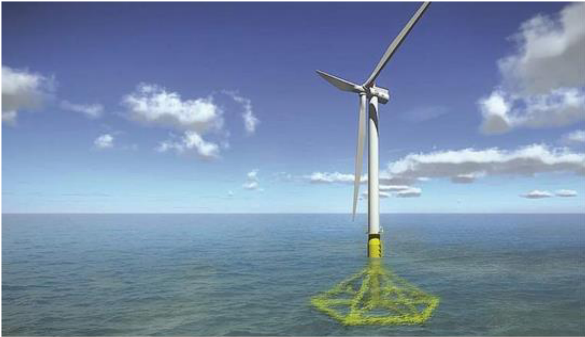
Figura 9 - Particolare della fondazione galleggiante di tipo floating
