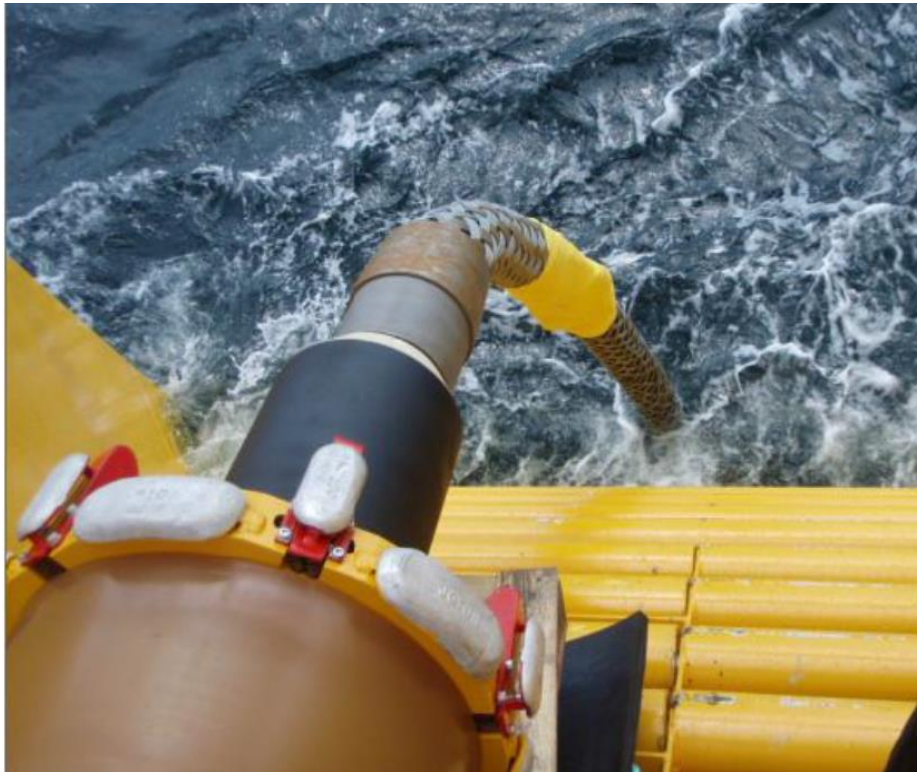
Figura 30 - Operazioni di installazione del cavo dinamico
