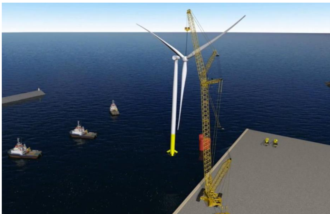
Figura 28 - Operazione di sollevamento del rotore della turbina
