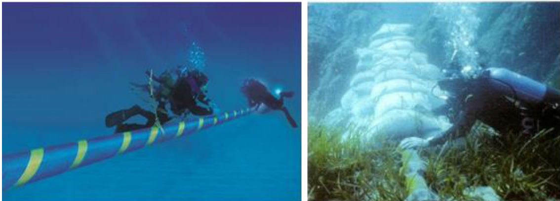
Figura 17 - Installazione e sistema di protezione di cavidotti marini adagiati sul fondale
