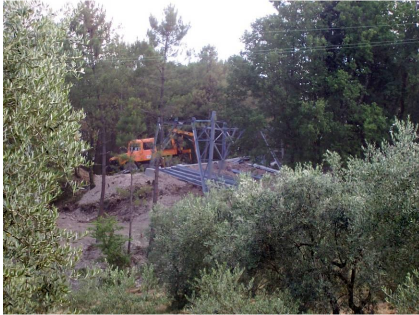
Foto 1 - Esempio di area di micro cantiere
