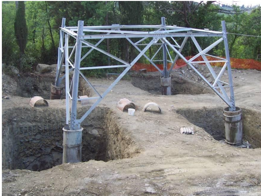
Foto 2 - Esempio di fondazione di un sostegno
