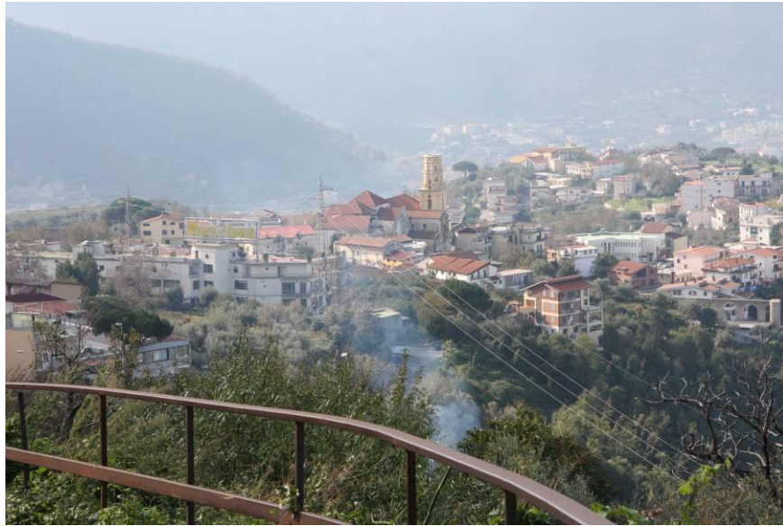
Foto 5 - Elettrodotto da demolire nella frazione Piazza Roma (Lettere)
