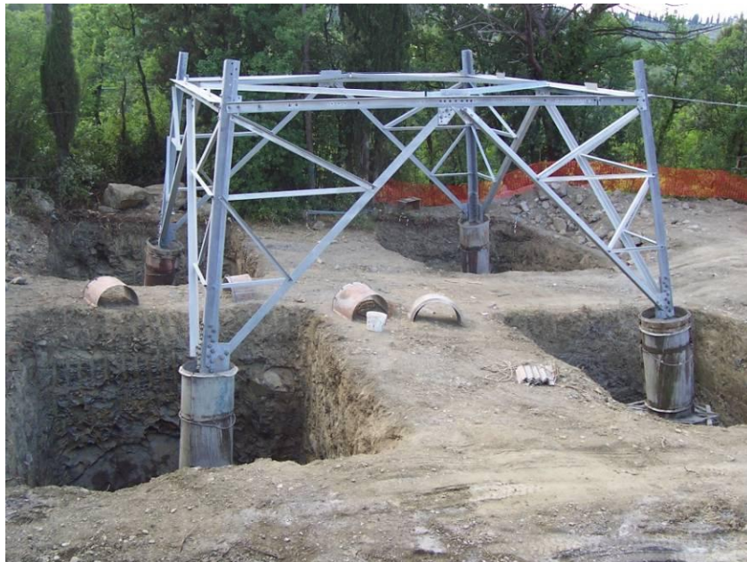
Foto 2 - Esempio di fondazione di un sostegno
