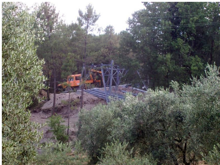
Foto 1 - Esempio di area di micro cantiere
