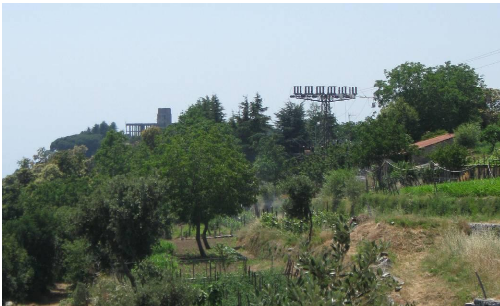
Foto 7 - Un portale che verrà demolito in prossimità del Castello Lauritano
