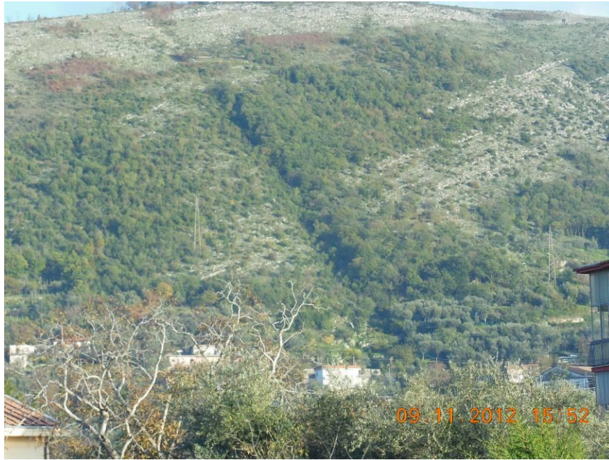
Foto 3 - Versante di ubicazione dei sostegni VAL1, VAL2 e VAL3. Sono molto evidenti le esposizioni degli stati calcarei
