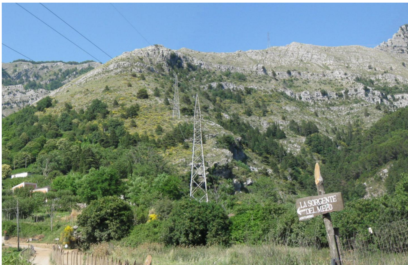
Foto 5 - la visibilità dei sostegni nella fascia 0 - 600 mt
