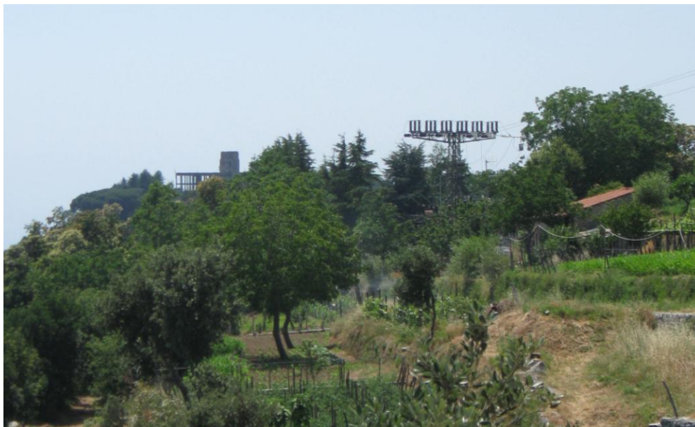
Foto 3 - una portale che verrà demolito in prossimità del Castello Lauritano
