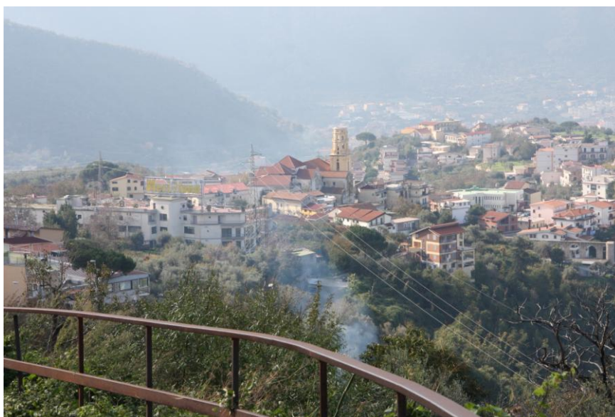
Foto 1 - Elettrodotto da demolire nella frazione Piazza Roma (Lettere)
