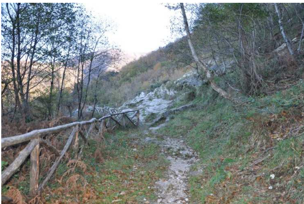
Figura 28. Anomalie 3-4. Verifica sul campo
