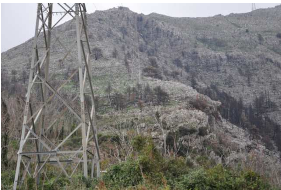
Figura 30. Anomalia 7. Verifica sul campo
