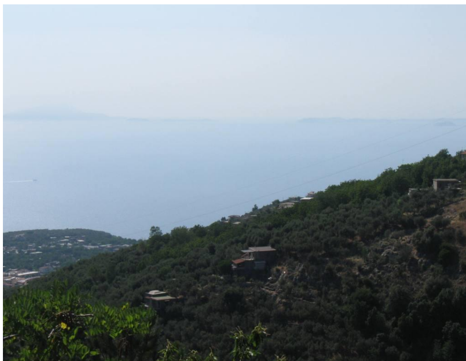
Foto 12 – Oliveti nella fascia collinare che domina il golfo di Sorrento, sovrastati da linee aeree da demolire
