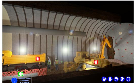
Lo scavo al fronte viene eseguito utilizzando un escavatore dotato di martello demolitore. Prima di dare inizio ai lavori, l'escavatorista verificherà il corretto funzionamento del climatizzatore di bordo. Durante lo scavo, la cabina dell'escavatore sarà tenuta chiusa.
