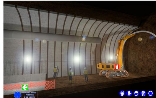
La lavorazione dello smarinio consiste nell'allontanamento del materiale scavato al fronte, mediante l'utilizzo di pale meccaniche, escavatori, dumpers e camion.
