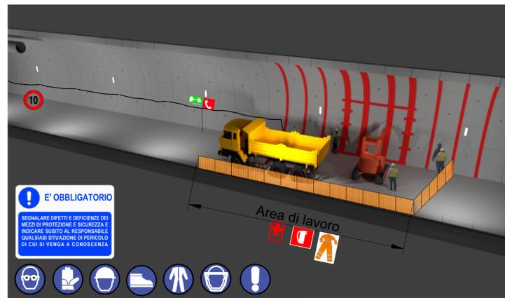
FASE 5 POSA IN OPERE DEL RIVESTIMENTO DI PRIMA FASE E SUCCESSIVA POSA DELL'IMPERMEABILIZZAZIONE
