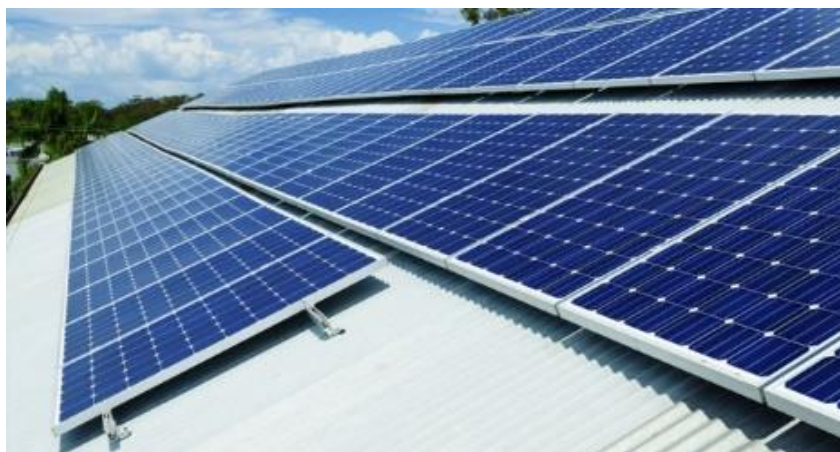
Figura 6-21 - Esempio di impianto fotovoltaico aderente la falda
