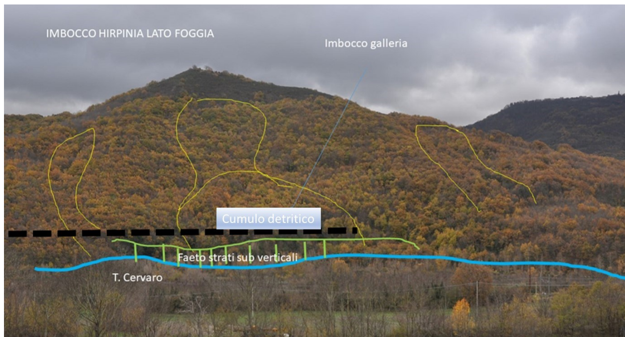
Figura 2-6 - Imbocco della galleria Hirpinia lato Foggia (km 41+500). Si rileva un antico terrazzo fluviale intagliato nel Flysch del Faeto calcareo su cui poggiano circa 10m di depositi colluviali e cumuli detritici. In giallo i perimetri dei presunti corpi. In nero con tratteggio, il viadotto e l'imbocco della galleria lato Foggia.
