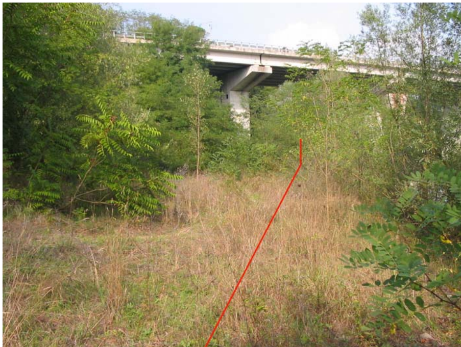
Foto 2.3/B: Area 5 – Passaggio sotto la superstrada E45
