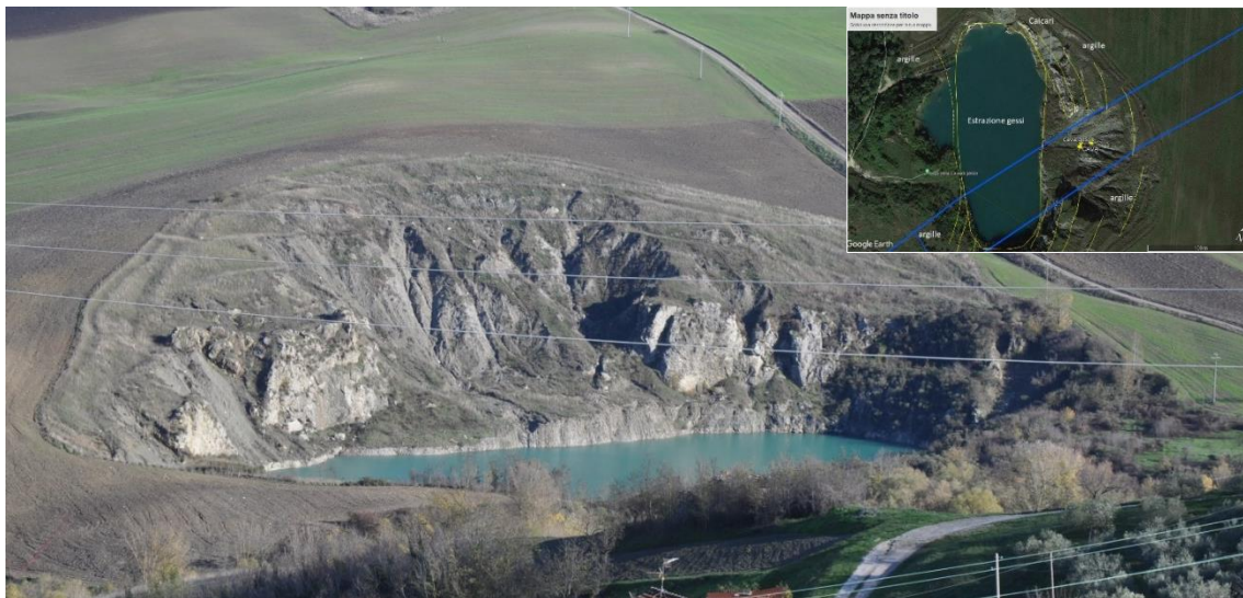
Figura 2-7 - Cava di gesso che sarà attraversata in profondità dalla galleria al km 56.200
